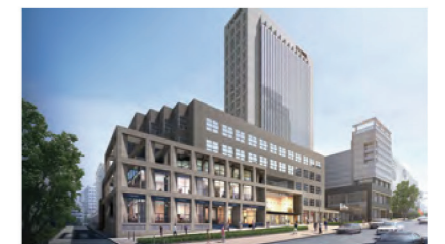
S-TOWER 리모델링 1·2차공사 발 주 처 : 글로벌세아 수행범위 : C 위 치 : 서울 수행기간 : 2018. 10 ~ 2021. 04
