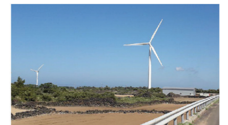
행원마을 풍력 발전소 설치공사
